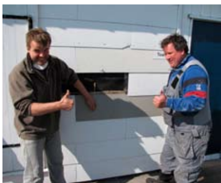
Ralf og Geir i gang med utskifting av knekte veggplater.
