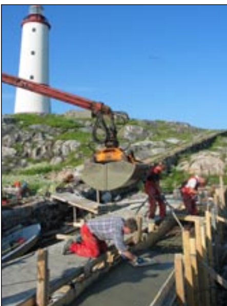
Støpearbeidene i full gang.
